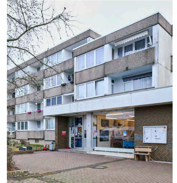
Begegnungshaus Roggendorf/Thenhoven in der Siedlung Im Mönchsfeld
